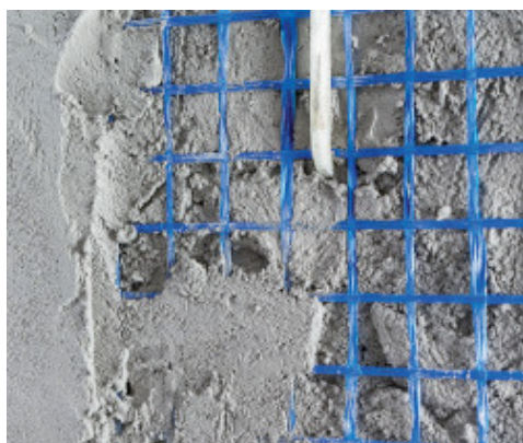
Applicazione del secondo strato di MapeWall Intonaca & Rinforza
