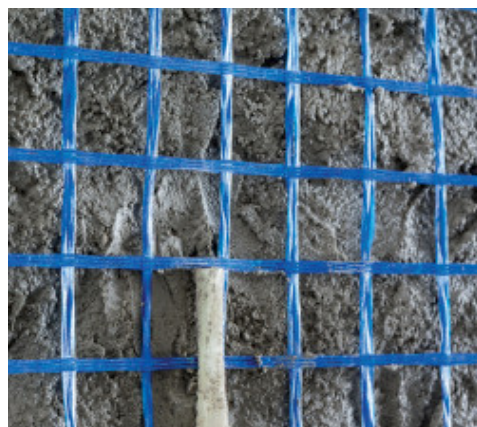
Posa di Mapenet EM
