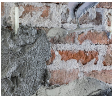
Applicazione del primo strato di MapeWall Intonaca & Rinforza
