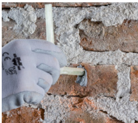
Posa di Mapenet EM Connector
