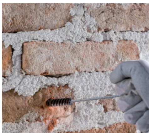
Asportazione delle polveri dai fori
