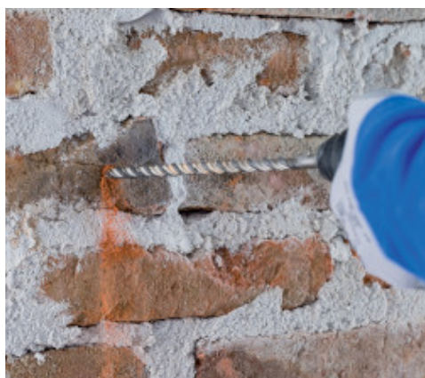
Realizzazione dei fori
