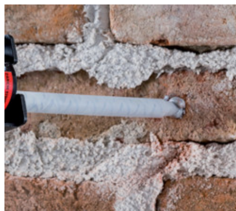
Applicazione di fissaggio chimico
